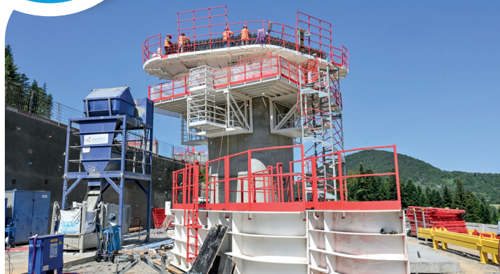
Viaduc du Roudesse: construction d'une pile
