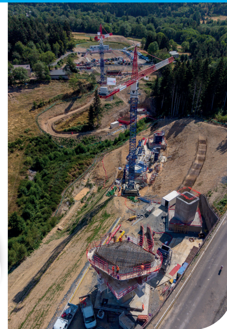
Viaduc du Roudesse: réalisation des fondations
