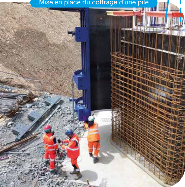
Mise en place du coffrage d'une pile
