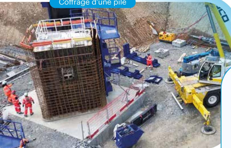
Coffrage d'une pile
