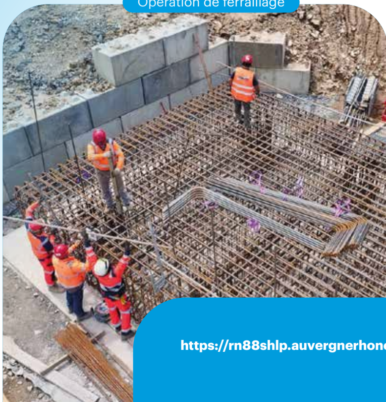
Opération de ferrailage
